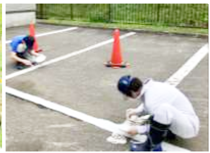
現場実習「駐車場の白線引き」
